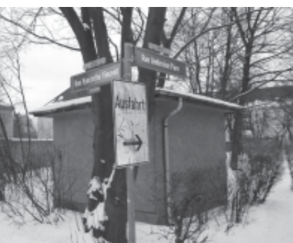
Cité Pasteur: Letzte Ausfahrt „Abriss“?
